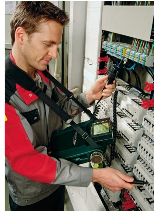
Merenje se obično može raditi sa 2-polnim adapterom kada se ispituju RCD-ovi i kada se meri otpornost petlje. Tada nije neophodno povezivanje na sva tri pola (L, N, PE).
